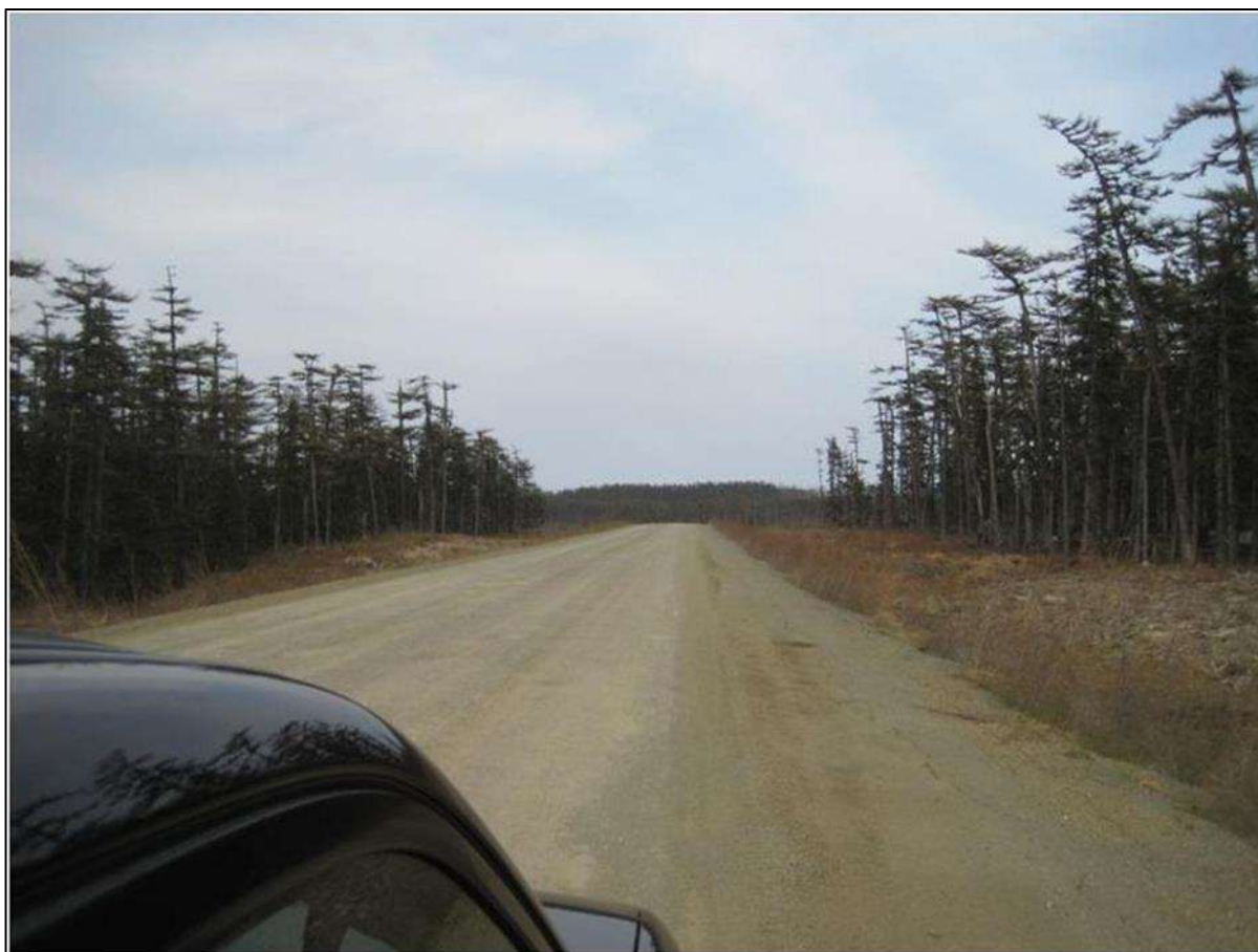
Рисунок 5-7 Подъездная дорога от территории ОБТК к берегу Охотского моря
