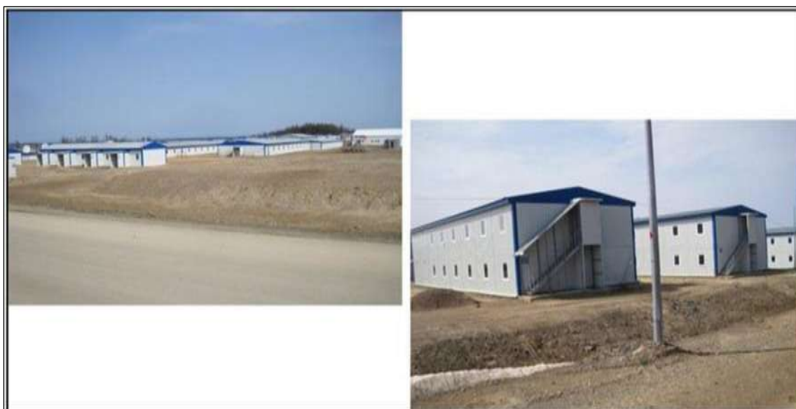
Рисунок 5-4 Жилые здания, которые будут восстановлены в вахтовом поселке строителей на территории ОБТК
