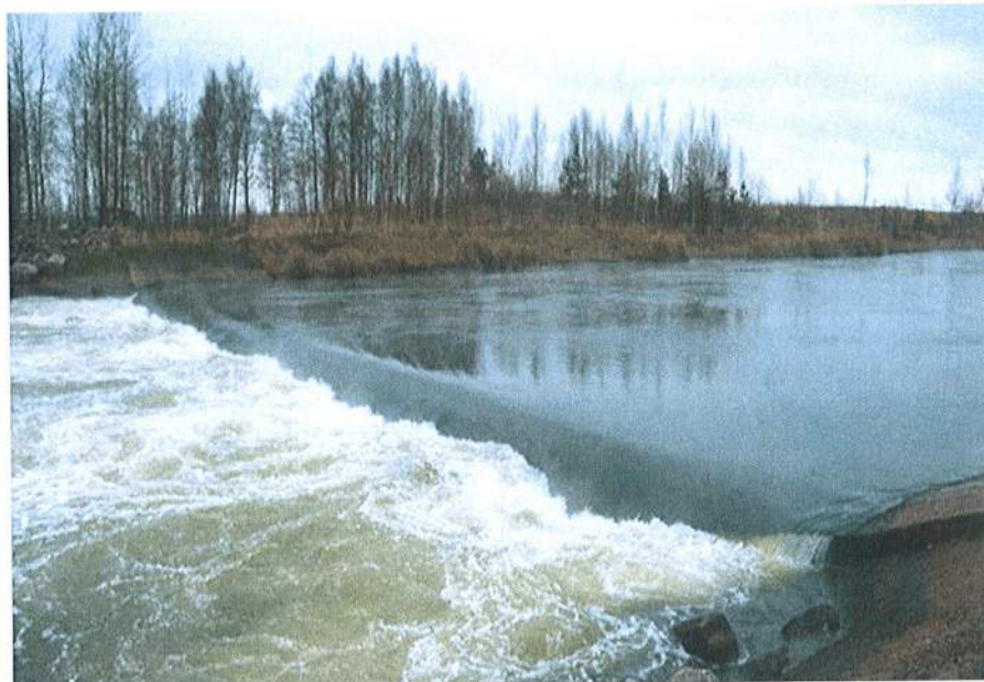
Рисунок 2.1.2.3- Вид отводящего канала II очереди действующей ЛАЭС на участке концевого сооружения при низком уровне воды в Финском заливе (09.11.2010)
