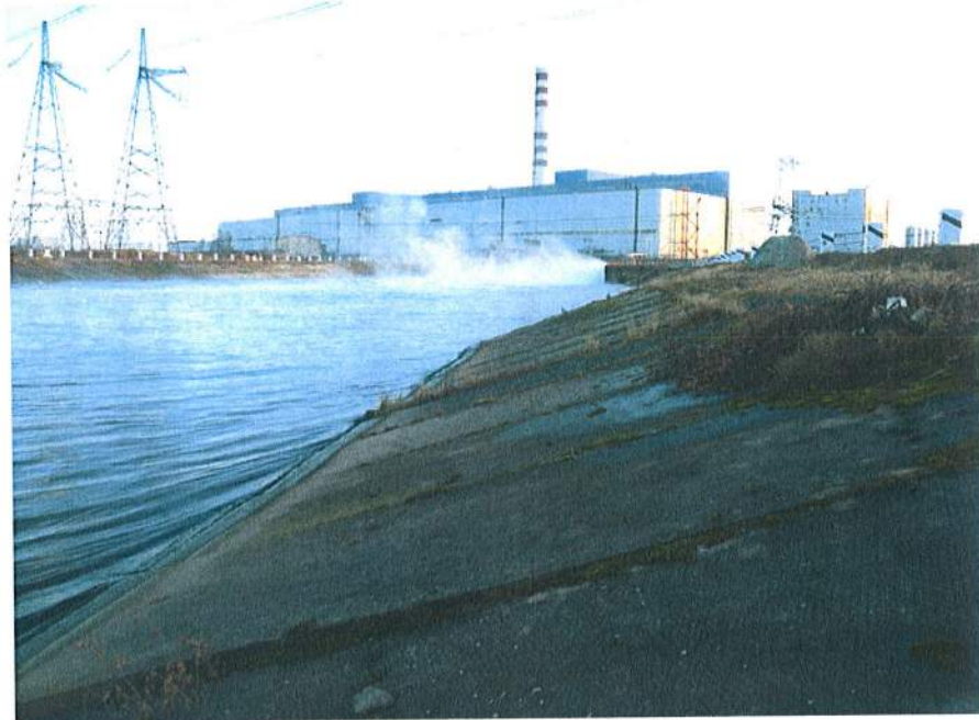
Рисунок 2.1.2.2 - Вид верховья отводящего канала II очереди действующей ЛАЭС
