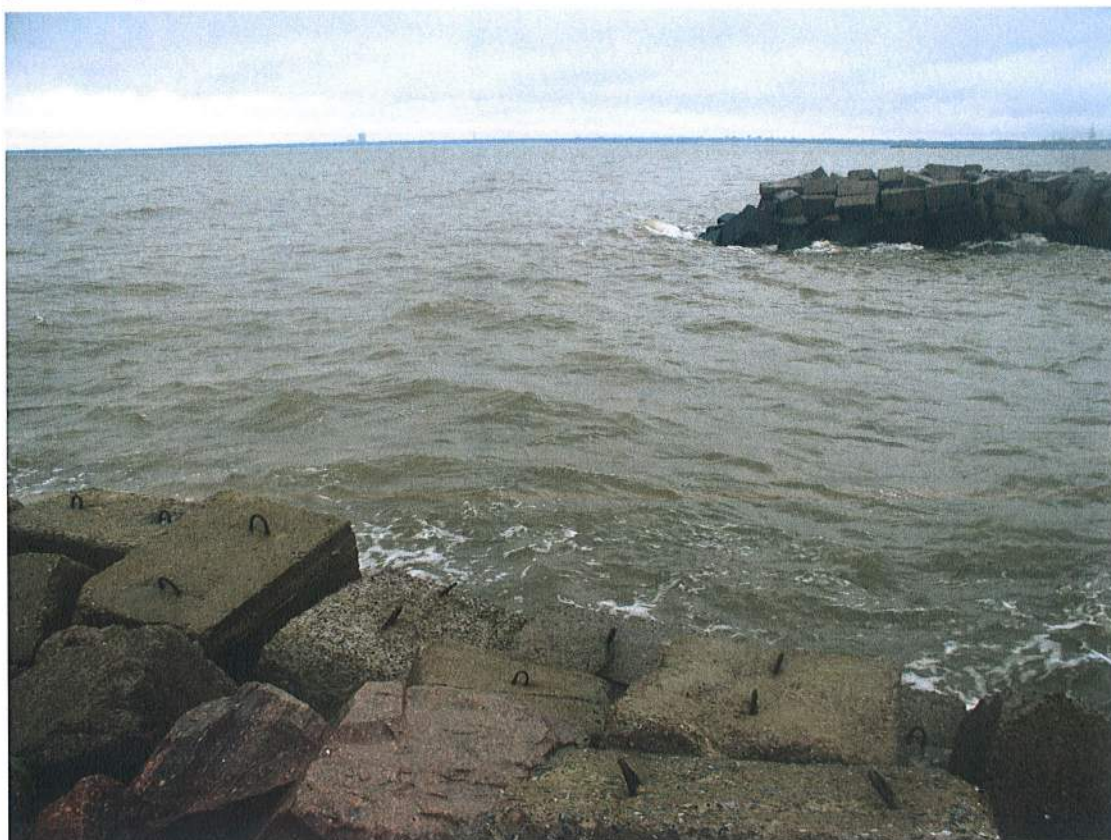
Рисунок 3.3.2.6.1.4.1- Исток водозаборного канала НИТИ и II очереди ЛАЭС
