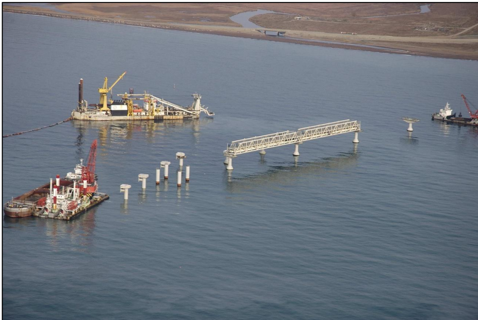
Рисунок 1.4 Строительство причала отгрузки СПГ
