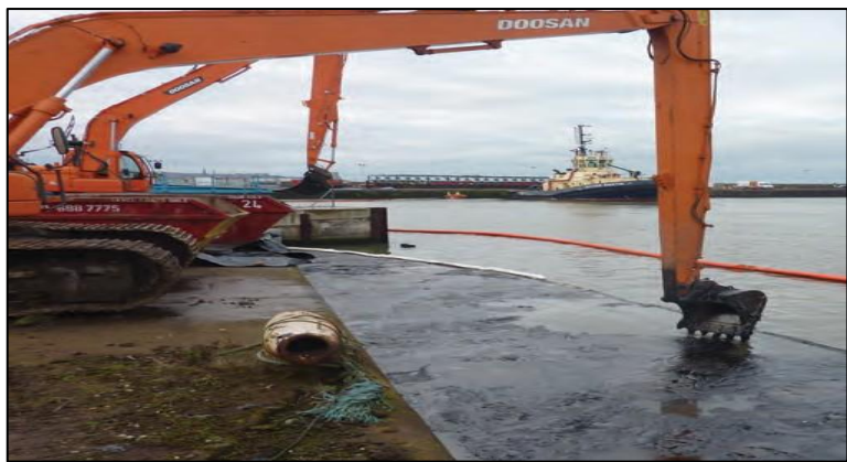
Рисунок 5.12 Строительные машины, которые используются для удаления нефти из области порта
