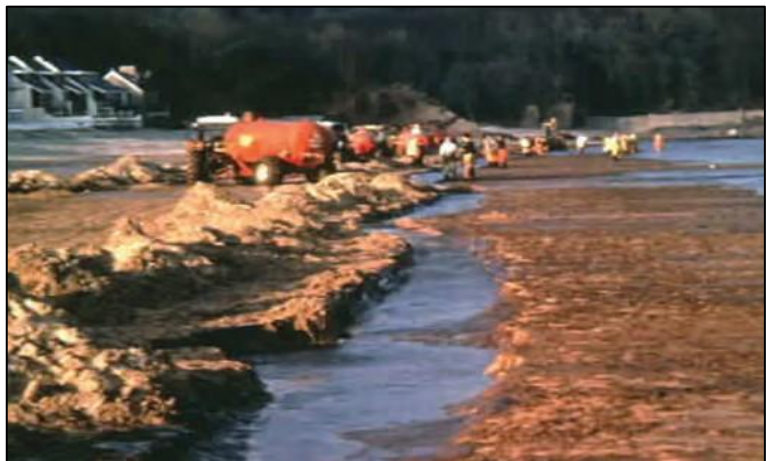
Рисунок 5.16 Вакуумные резервуары, которые используются для удаления нефти, которая была смыта в траншеи
