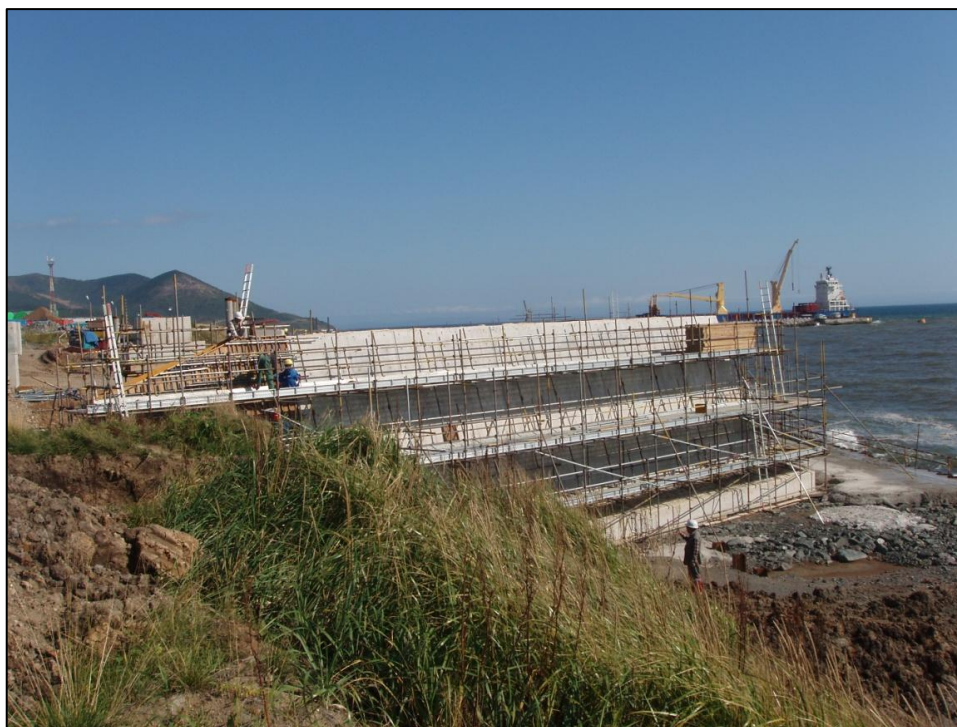
Рисунок 1.5 Строительство подходной эстакады
