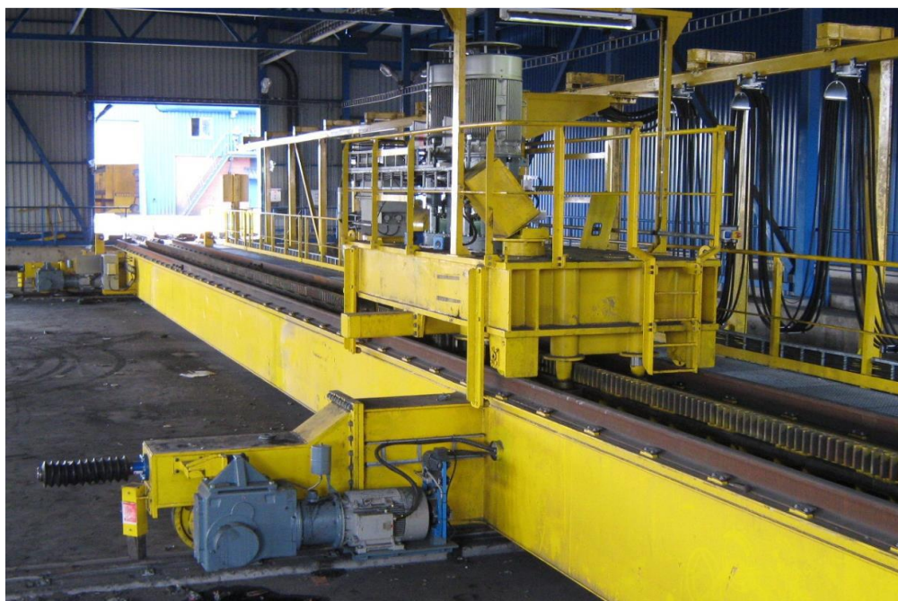
Рисунок 8.1 - Здание трансбордера. Перегрузочная платформа с маневровым устройством.
