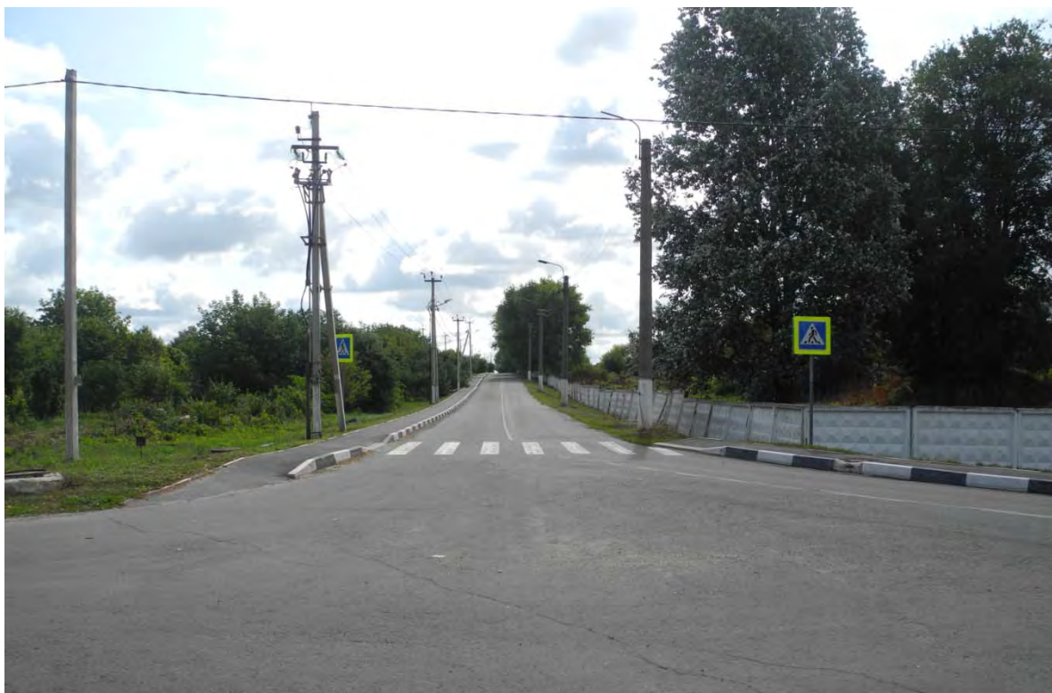
Рисунок 2.4.-2. Фотоснимок участка строительства
