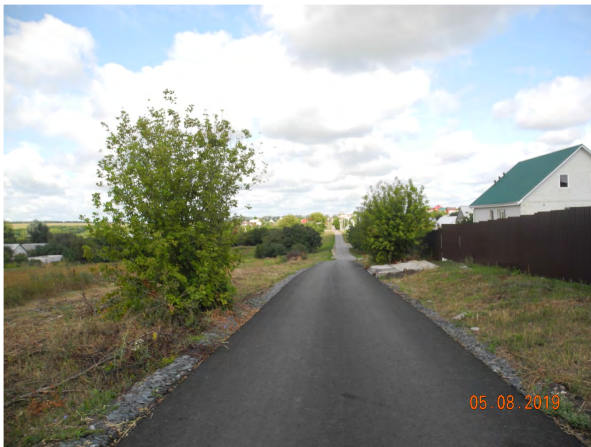
Рисунок 2.4.-1. Фотоснимок участка строительства
