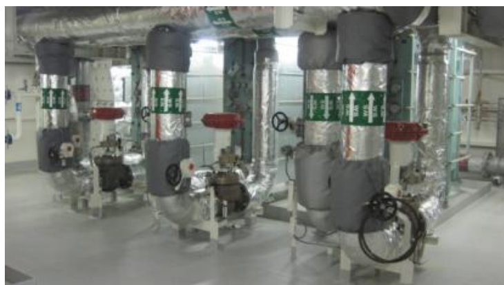
Рисунок 7.7 – Система охлаждения тосола забортной морской водой
