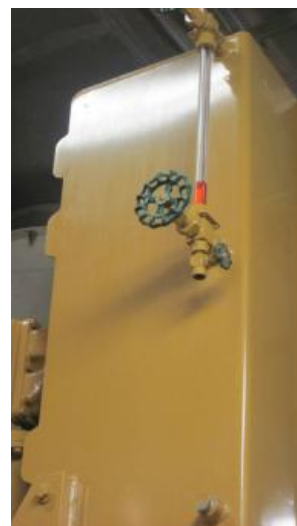
а – бак с тосолом; б – уровень тосола в баке Рисунок 7.6 – Система охлаждения дизель-генераторов
