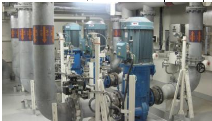
Рисунок 7.8 – Система охлаждения вспомогательных механизмов
