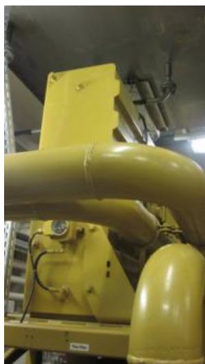
а – бак с тосолом; б – уровень тосола в баке Рисунок 7.6 – Система охлаждения дизель-генераторов
