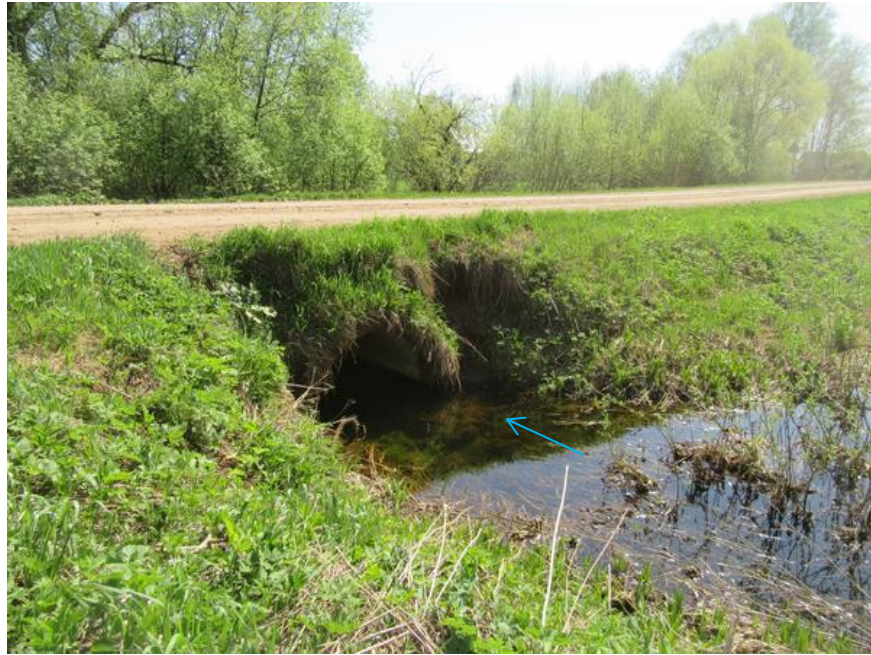
Фото 5 - Водопрпускное отверстие через насыпь автодороги для пропуска стока ручья б/н №1 ПК1+10,2
