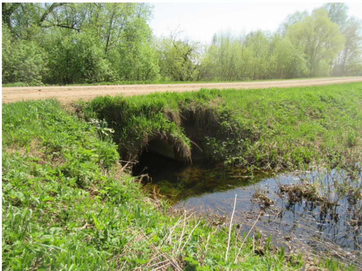
Рисунок И4 – Водопрпускное отверстие через насыпь автодороги для про-
