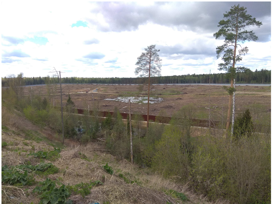
Рисунок 3.2.3 Территория строительного участка, примыкающая к участку изысканий
